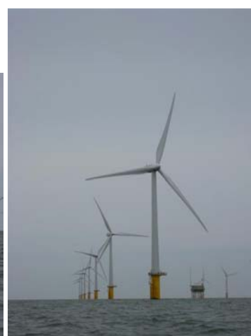
Parque eólico de Thanet, (parque eólico costa afuera mas grande del mundo), a 12km dentro del mar del Norte, en la costa de Kent, 100 turbinas Vestas V90 de 3MW cada una, para un total de 300 MW. Fue contruido en 100 días, una turbina por día, y es propiedad de Vattenfall.
