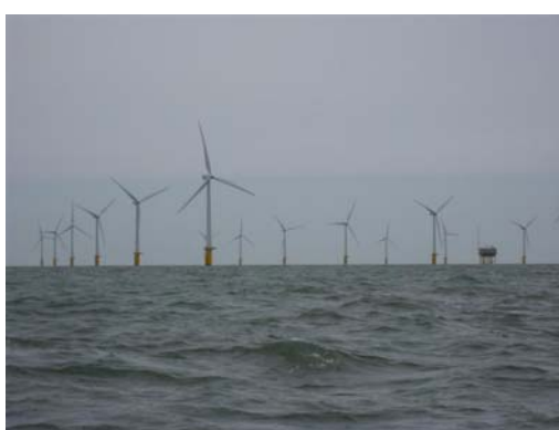
Parque eólico de Thanet, (parque eólico costa afuera mas grande del mundo), a 12km dentro del mar del Norte, en la costa de Kent, 100 turbinas Vestas V90 de 3MW cada una, para un total de 300 MW. Fue contruido en 100 días, una turbina por día, y es propiedad de Vattenfall.
